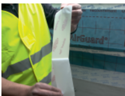
17. Nulupkite atskyrimo juostelę nuo DuPont™ AirGuard® juostos...
