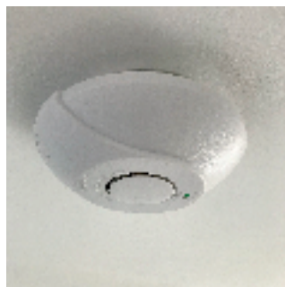
Dūmų detektorius, maitinamas elektros tinklo įtampa
