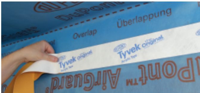
Klijuokite Tyvek® Tape Plus juostą arba Tyvek® dvipusio lipnumo juostą (akrilinę) išlaikydami 100 mm užlaidas.
