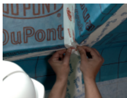
18. ... lanksti juosta, kurią galima naudoti kampų ir bet kokių kitų sudėtingų elementų sandarinimui
