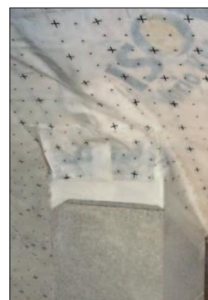
Vidinės stogo dangos plėvelės prijungimas
