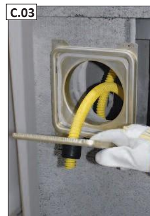
C.03 Nuimkite „BlowerDoor“ kondensato išleidimo dureles ir ištraukite karščiui atsparaus DN 40 vamzdžio adapterį su sifono žarna.
