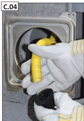
C.04 Nuo sifono žarnos nusukite karščiui atsparaus DN 40 vamzdžio adapterį.
