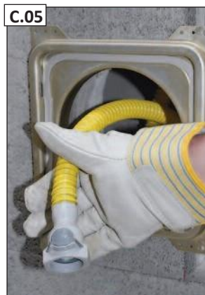
C.05 Kondensato surinkimo maišelio jungiamąją dalį užmaukite ant 3/4" sifono žarnos atvamzdžio.
