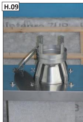
H.09 Kad neįkristų, apžiūros dangtelis pritvirtintas vieline kilpa. Bent kartą per metus patikrinkite vielinės kilpos tvirtumą ir, jei reikia, ją pakeiskite.
