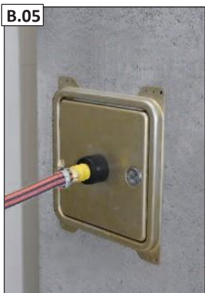
B.05 Pavyzdys: kondensato nuvedimas per 3/4" žarną.
