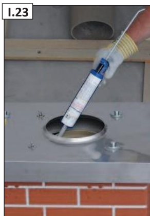
I.23 Užtepkite storą siūlių sandarinamojo mišinio „RAPID fugendicht“ sluoksnį.
