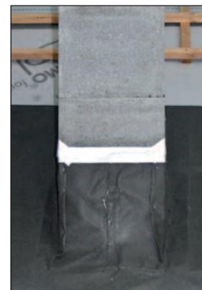
Išorinės stogo dangos plėvelės prijungimas
