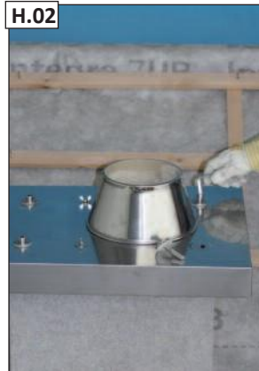
H.02 Iš išmetamųjų dujų traukos pusės nuo dengiamosios plokštės iš nerūdijančiojo plieno atsukite abu cilindrinis varžtus su silikoninėmis tarpinėmis ir poveržlėmis.
