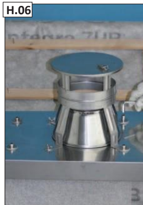
H.06 Uždėkite poveržles, įstatykite cilindrinis varžtus ir prie dengiamosios plokštės iš nerūdijančiojo plieno prisukite lietaus stogelį „EAGLE“.
