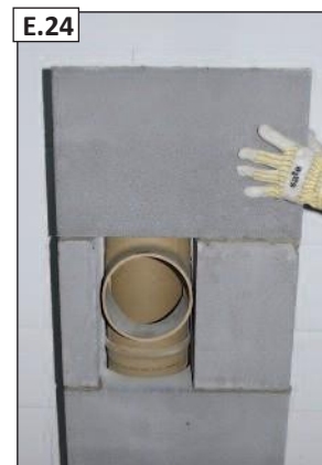
Uždėkite kitą blokelį.
