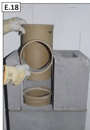
Įstatykite dūmtraukio prijungimo trišakį. L= 33 cm, jei \varnothing iki 20 cm L= 66 cm, jei \varnothing < 25 cm
