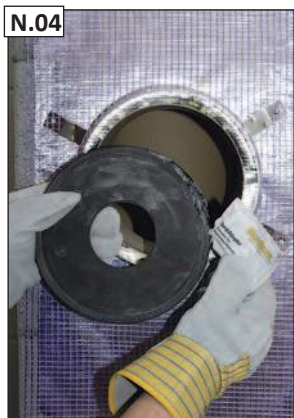
Palei visą kišamojo adapterio kontūrą užtepkite lubrikanto.
