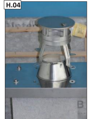
H.04 Ant dengiamosios plokštės iš nerūdijančiojo plieno uždėkite silikonines tarpines. Uždėkite lietaus stogelį „EAGLE“.
