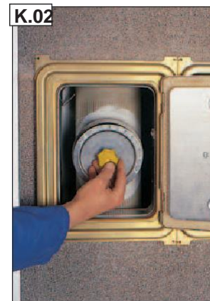
K.02 Įdėkite standartinį apžiūros užraktą.
