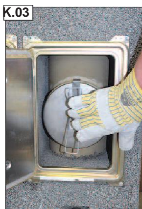
K.03 Apžiūros užraktas, naudojant kietąjį kūrą.
