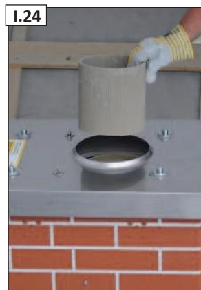
I.24 Įdėkite atpjautą galinį profiliuotąjį vamzdį.
