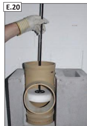
Siūlių glaistykle nubraukite siūlių sandarinimo priemonės „RAPID fugendicht“ likučius.
