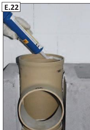
Ant kaištinės jungties užtepkite storą „RAPID fugendicht“ sluoksnį.
