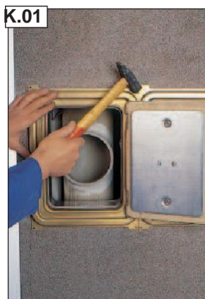
K.01 Prie blokelio prikalkite valymo dureles.
