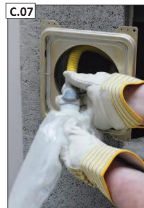
C.07 Prie jungiamosios dalies prijunkite kondensato surinkimo maišelį.
